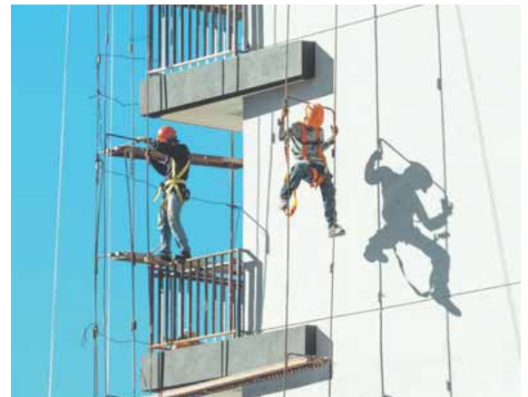
Trabajadores de la construcción realizando labores en altura.
