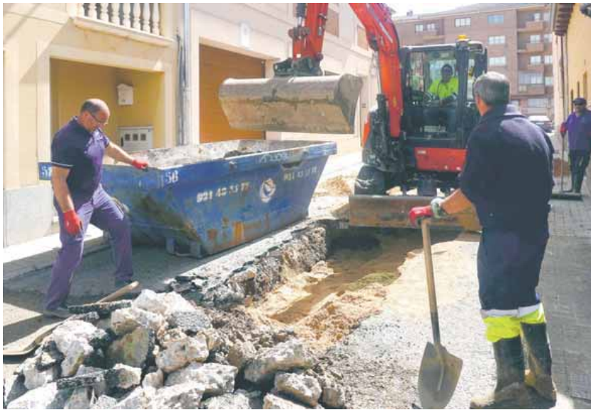
Obras de reparación de una tubería en la calle Alonso Ledesma de Segovia.
