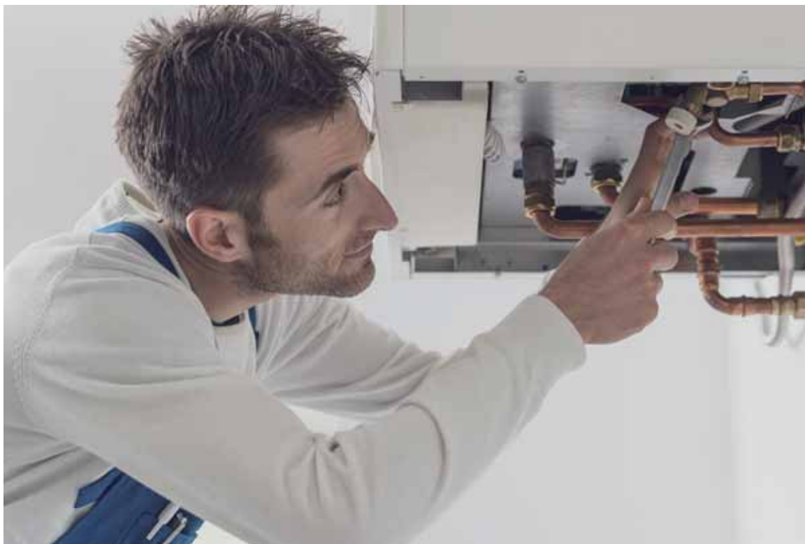
La revisión de las calderas es esencial para el ahorro de energía en el hogar.
