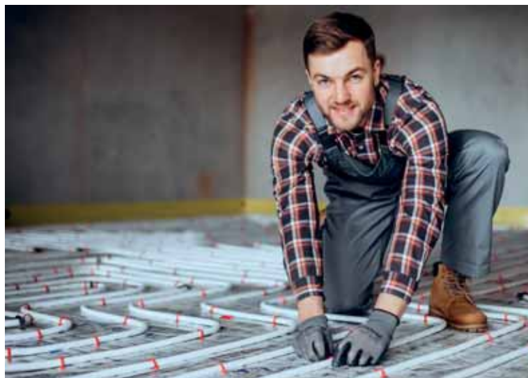
Instalación de suelo radiante.
