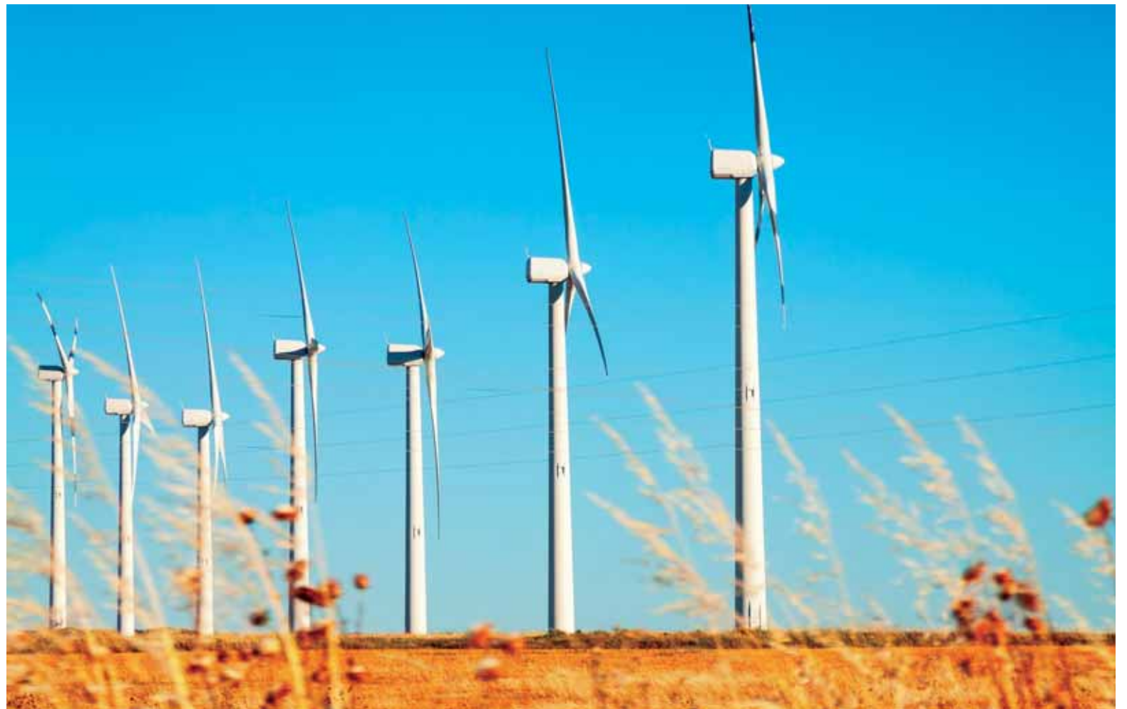
La energía eólica aporta casi la mitad de la electricidad que se consume en Castilla y León.
