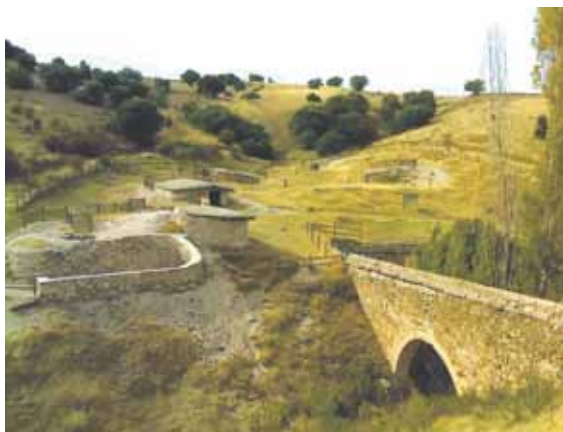
Hornos de cal del Zanco y el singular acueducto que aún conserva el pueblo.
