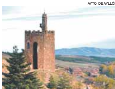
Torre de la Martina en el castillo de Ayllón.
