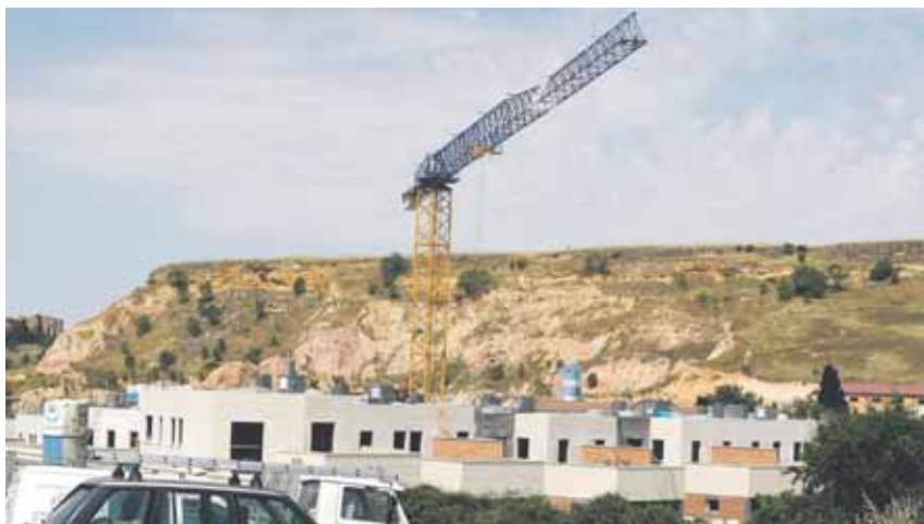
Imagen de archivo de unas obras en construcción en una localidad segoviana.
