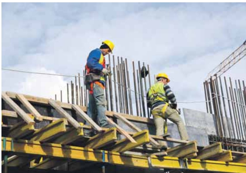
Trabajadores examinando una obra.
