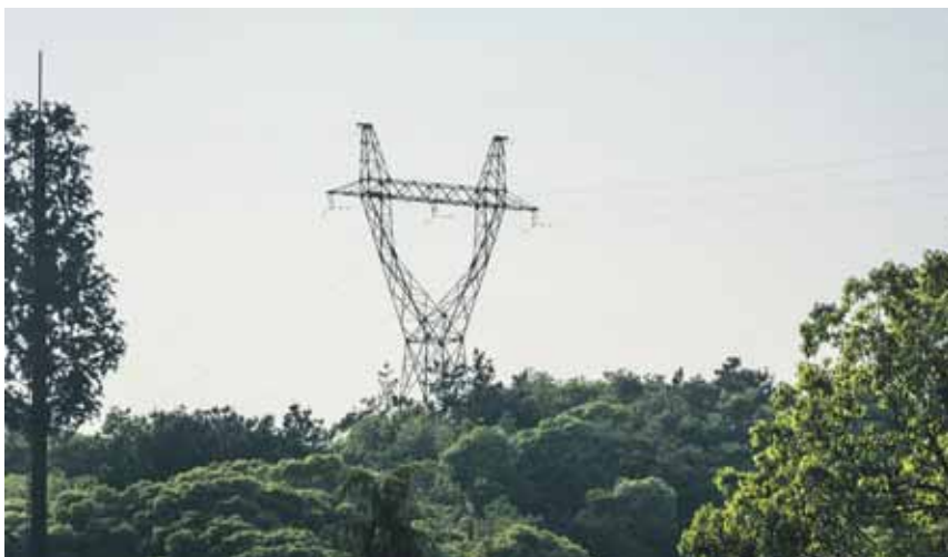
Poste eléctrico en un paraje frondoso.
