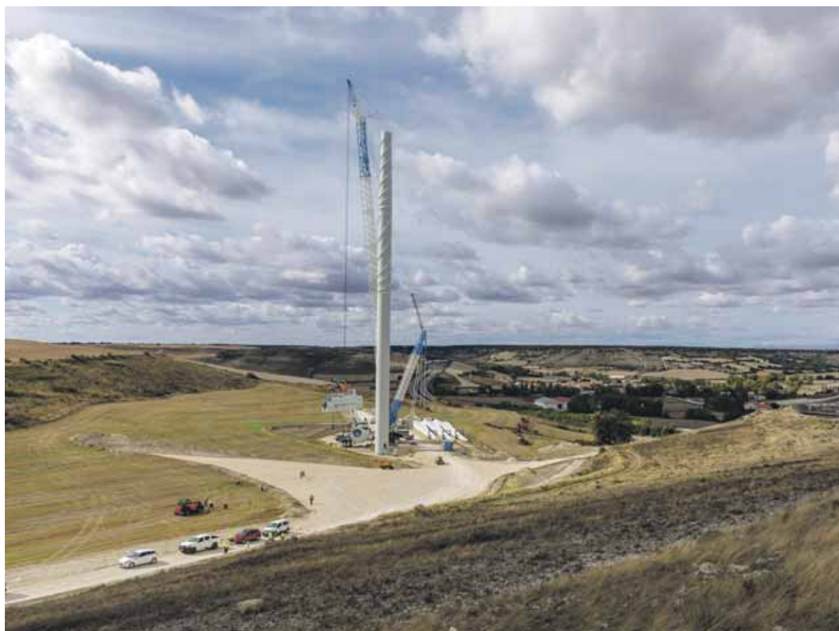
Iberdrola instala el primer aerogenerador del complejo eólico Herrera II.
