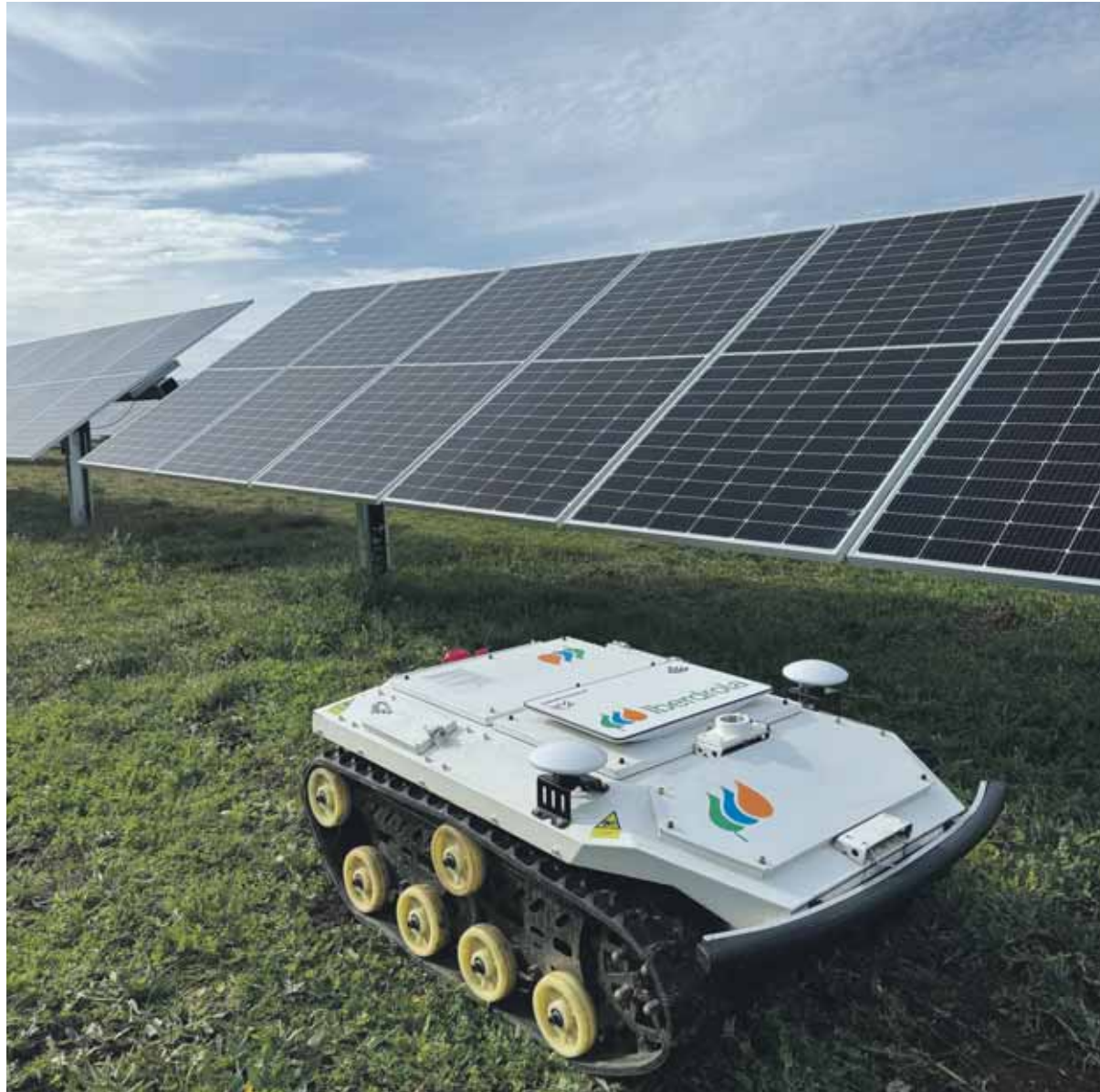
El Robot castellano y leonés en la planta fotovoltaica Villarino.
