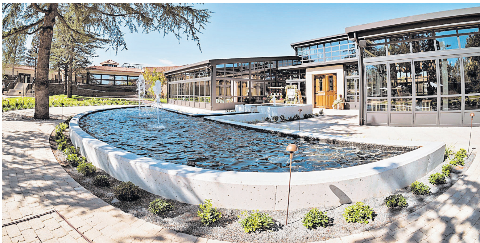
El edificio acristalado, Alhaja, uno de los espacios de Zibá preparados para albergar eventos de carácter social y empresarial.
