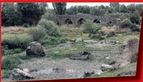
Puente El Naranjo sobre el río Voltoya
