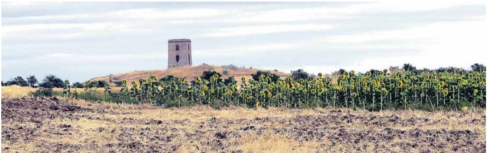
La torre del telégrafo óptico de Codorniz está en un cerro en cuyas laderas se encuentran una veintena de bodegas soterradas y excavadas a mano en piedra de arenisca.
