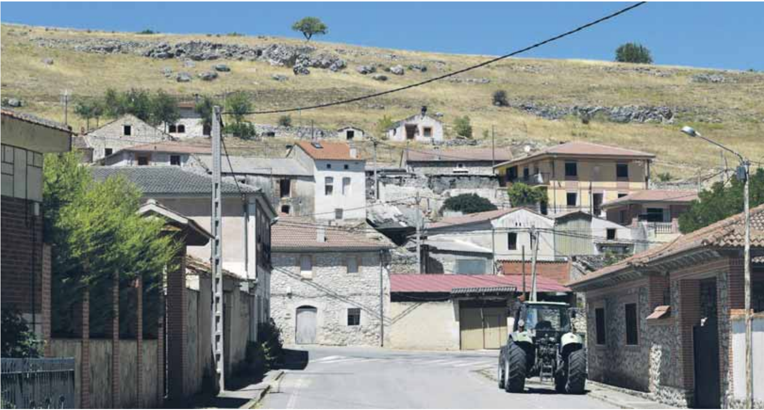
Aldeasoña ofrece numerosas rutas para senderistas y múltiples bodegas excavadas en roca, como se puede observar en la parte superior de la foto.
