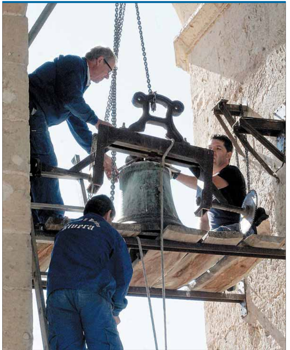
Los campaneros trabajan en una de las campanas de la catedral para retirarla. / M.GALINDO
